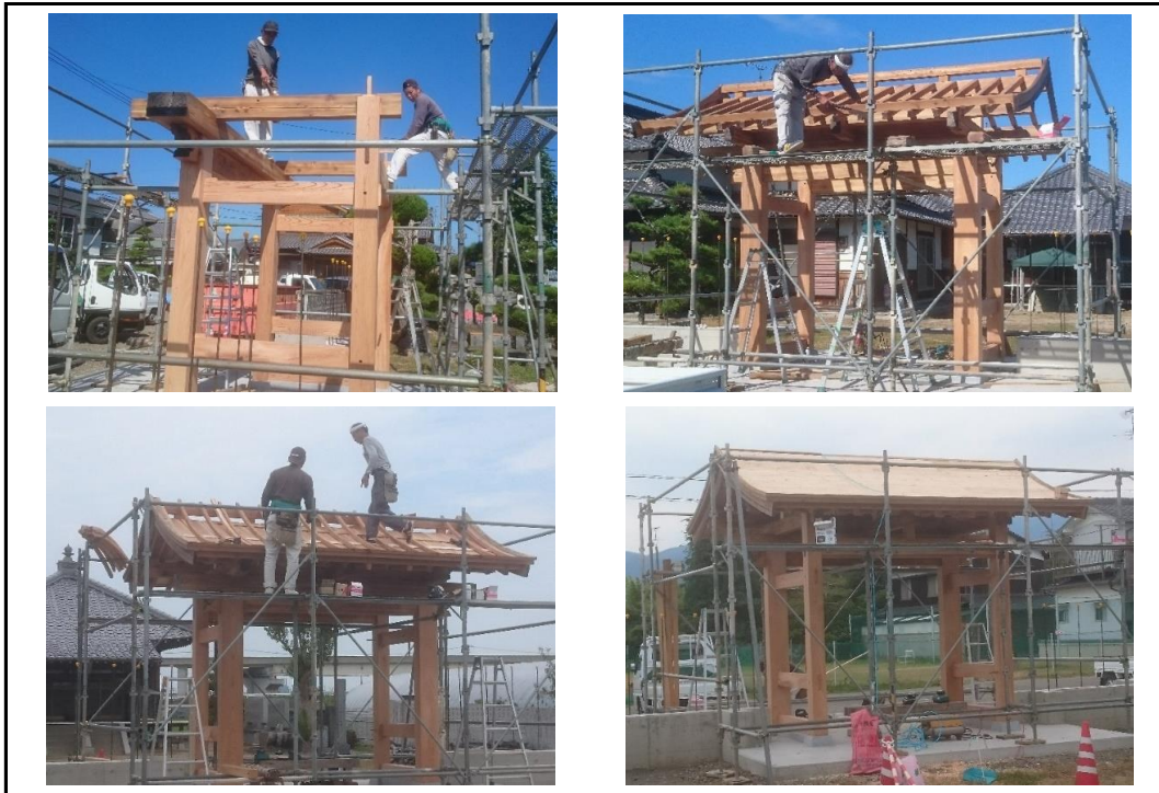
山門上棟 (平成30年9月5・6日)
